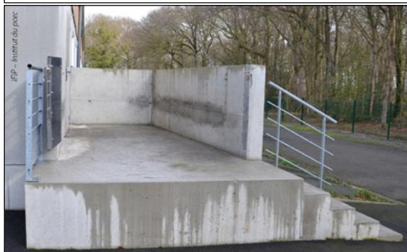
Figure 7 : exemple de quai de chargement adapté
