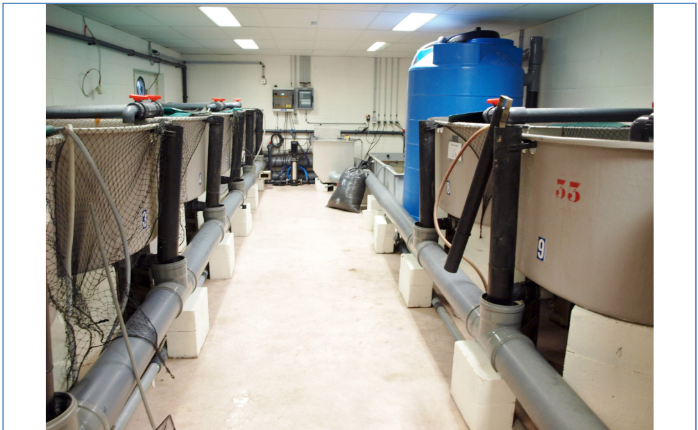
Figure 20. Circuit recirculé destiné au grossissement des juvéniles et au maintien des géniteurs de barbeau.
