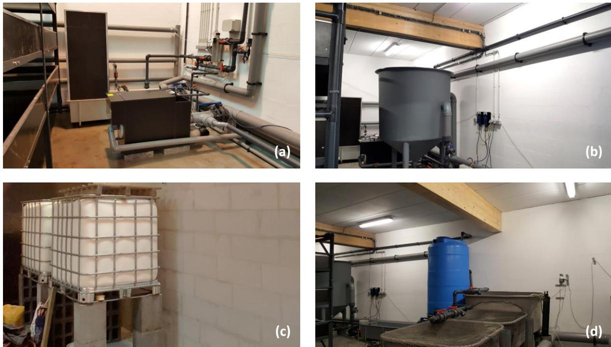
**Figure 12.** Illustration de différents équipements du système : (a) tambour filtrant, bac de charge et stérilisation UV ; (b) décanteur (vortex) ; (c) réserve d'eau d'appoint ; (d) biofiltre.
