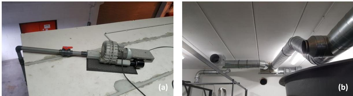
**Figure 13.** (a) Turbine d'aération ; (b) système de ventilation.
